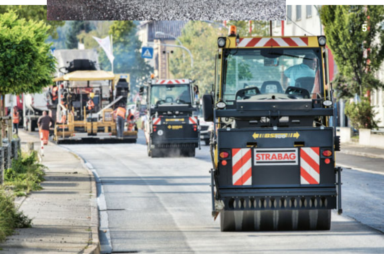
3–5 Einbau des CIAir® Asphalt-Belags mit dem Innovationsbunker, dem fertigerintegrierten Streuer und Walzen
