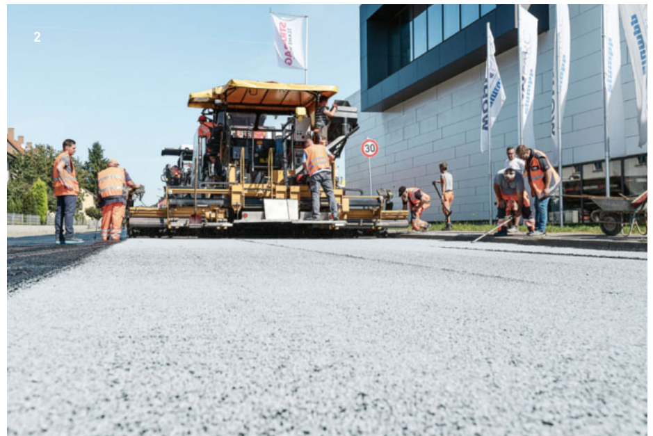
1+2 Basis für ClAir® Asphalt: Titandioxidhaltiges Abstreumaterial aus Ultrahochleistungsbeton (UHPC)
