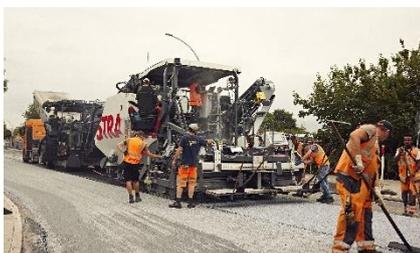
Bislang größtes CIAir® Asphalt-Projekt: Im August 2022 baute die STRABAG AG ihre schadstoff- und lärmindernde Asphaltdeckschicht auf einer Gesamtfläche von 18.000 m<sup>2</sup> im Industriegebiet Peute in Hamburg-Veddel ein.
