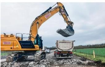
Die alte Betonfahrbahn wird abgebrochen und in unmittelbarer Nähe aufbereitet. Die recycelten Baustoffe, die in der Tragschicht und der Betondecke verbaut werden, stammen vollständig aus dem lokalen Materialkreislauf.
