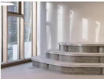
Beim Innenausbau kam im Zuge eines Pilotprojekts ein mobiler 3D-Betondrucker zum Einsatz, der flexibel Elemente drucken kann.
