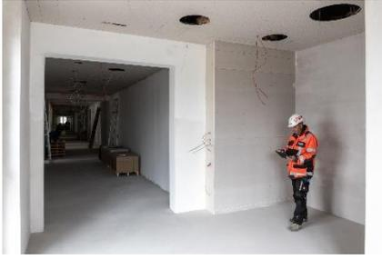
Die Rückführung der oberirdischen Geschoße in den Rohbauzustand ermöglicht eine vollständige Neugestaltung des Innenraumkonzepts, welches sowohl die Anforderungen moderner Pädagogik als auch jene eines integrierten Hortbetriebs erfüllt.
