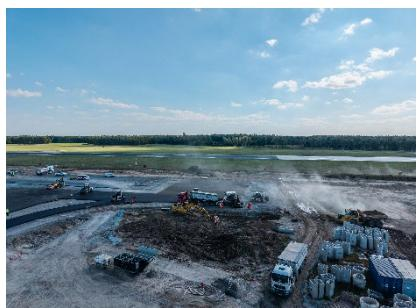
Ende Oktober wurde der Flughafen vollständig geschlossen, um sicherheitskritische Arbeiten zur Anbindung von vier neuen Rollwegen an die bestehende Start- und Landebahn durchzuführen.
