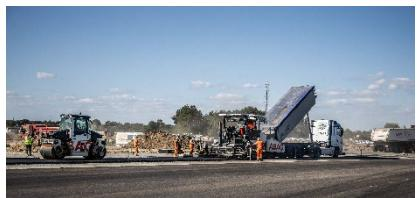
Im Zuge der Bauarbeiten werden 240.000 m<sup>2</sup> Asphalt und 110.000 m<sup>2</sup> Beton eingebaut.
