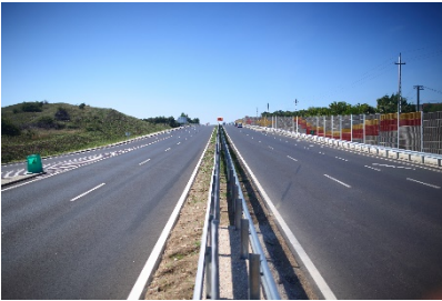
Visualisierung der baulich getrennten Fahrsteifen
