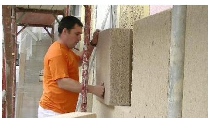
Die Platten sind vielseitig einsetzbar und eignen sich nicht nur als Dämmmaterial, sondern können auch als Akustikelemente, Lärmschutzabsorber sowie für die Dachbegrünung eingesetzt werden.
