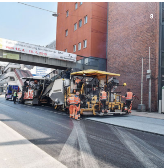
8 Asphaltbau an der Luftmessstation „Am Neckartor“ / 9 Grafische Darstellung der NO 2 -Messwerte bis August 2019 (Quelle: LUBW)
