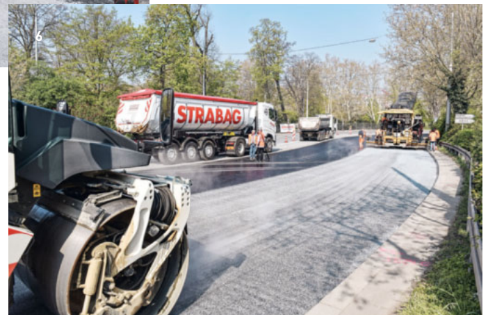
4 Innovationsbunker und Förderband am Fertiger / 5-7 Einbau vom CIAir® Asphalt auf der B14 „Am Neckartor“
