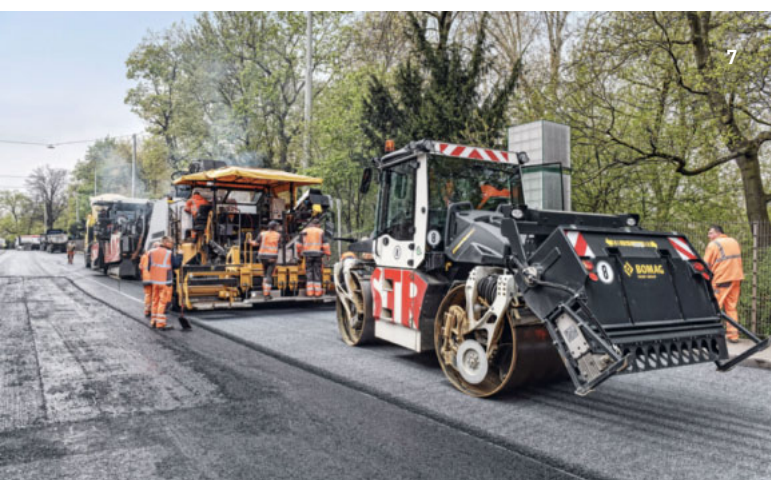
4 Innovationsbunker und Förderband am Fertiger / 5-7 Einbau vom CIAir® Asphalt auf der B14 „Am Neckartor“
