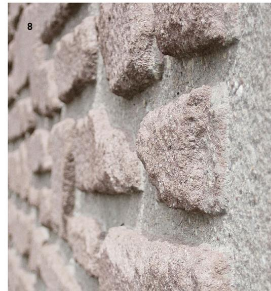
1 Bohr- und Verankerungsarbeiten Herkulesbauwerk Kassel / 2+4 Mauerwerks- und Natursteinarbeiten Kloster Eberbach, Eltville / 3 Ziegelsteinaustausch Kreuzkirche Bonn / 5 Spritzbetonauftrag über Matritze / 6 Relief-Karikatur Torkret Art® / 7 Spritzbetonsicherung mit Reliefoberfläche / 8 Spritzbeton Relief Torkret Stone®
