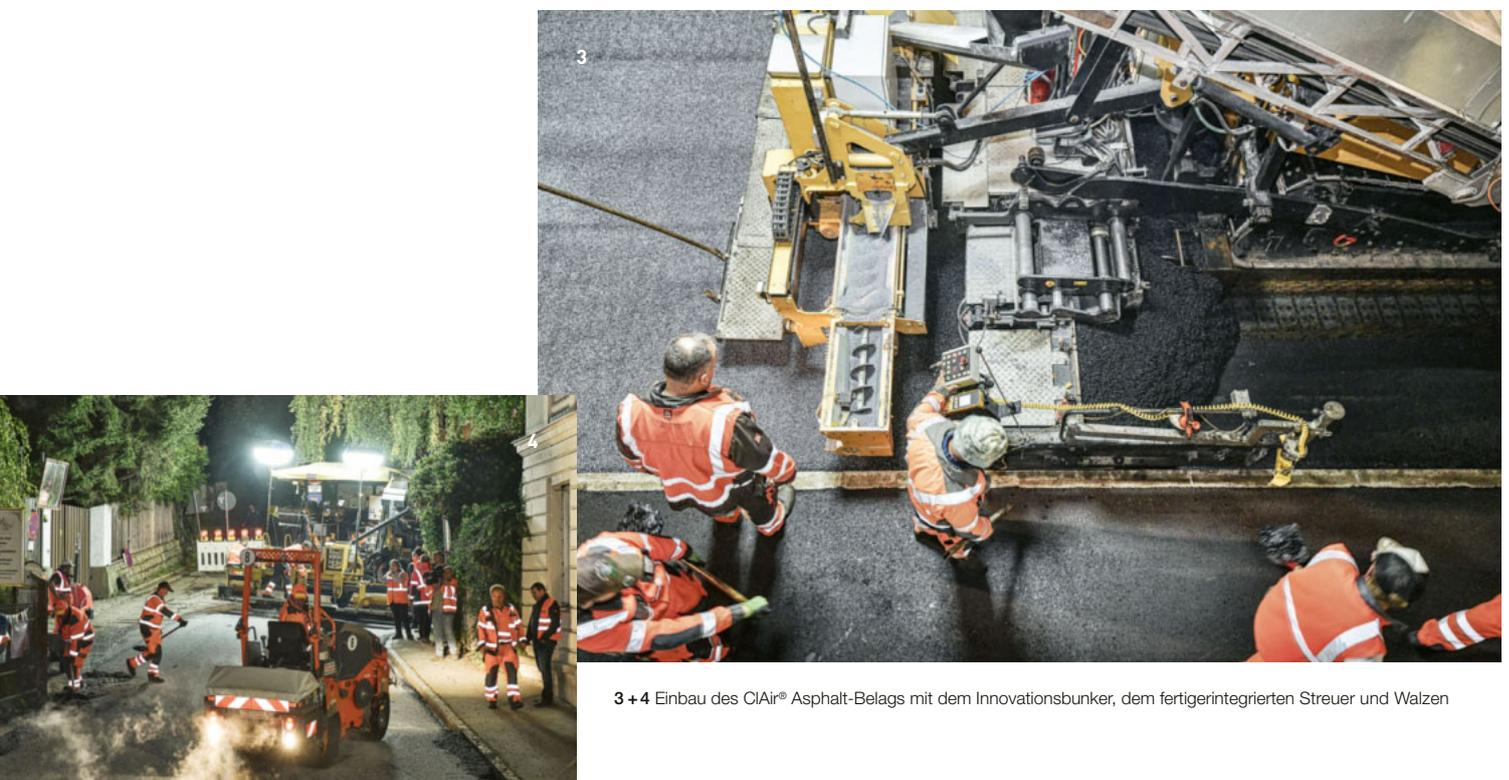
3 + 4 Einbau des CIAir® Asphalt-Belags mit dem Innovationsbunker, dem fertigerintegrierten Streuer und Walzen
