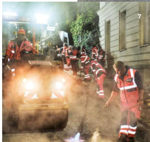
**5** Aufheizung der Fräskante vor dem Asphalteinbau/
