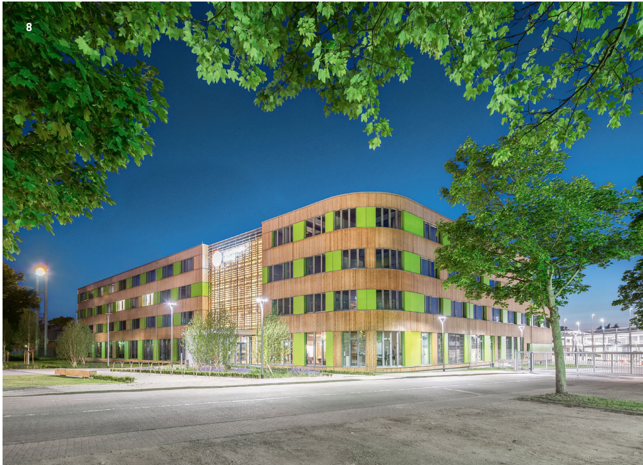
5+6 Anbau Bürogebäude, Ulm; © photodesign Armin Buhl / 7+8 Verwaltungsgebäude Stadtwerke, Lübeck; © Steffen Spitzner
