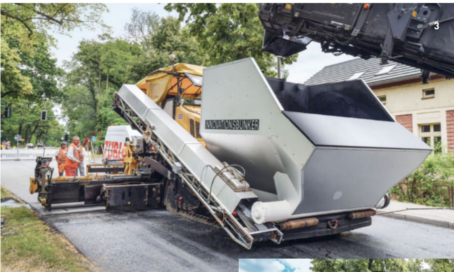
3–5 Einbau von ClAir® Asphalt mit dem fertigerintegrierten Streuer und Innovationsbunker
