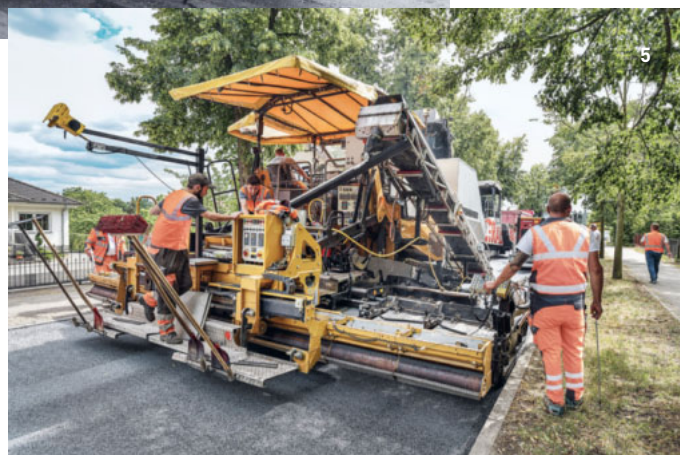
3–5 Einbau von ClAir® Asphalt mit dem fertigerintegrierten Streuer und Innovationsbunker
