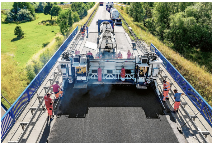
5 Einbau des Gussasphalts 6+7 Asphalt einbau (kompakte Bauweise) im InLine Pave-Verfahren
