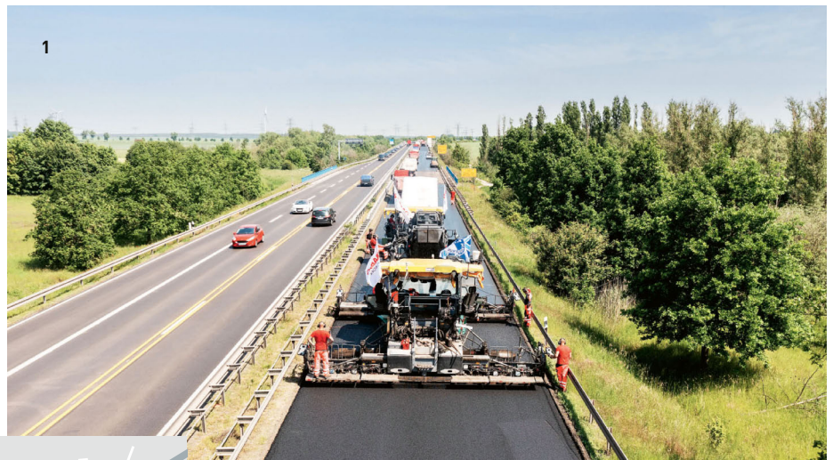
1 Einbau Kompaktasphalt im InLine Pave-Verfahren/ 2 Übersicht Erprobungsabschnitte und Referenzabschnitt
