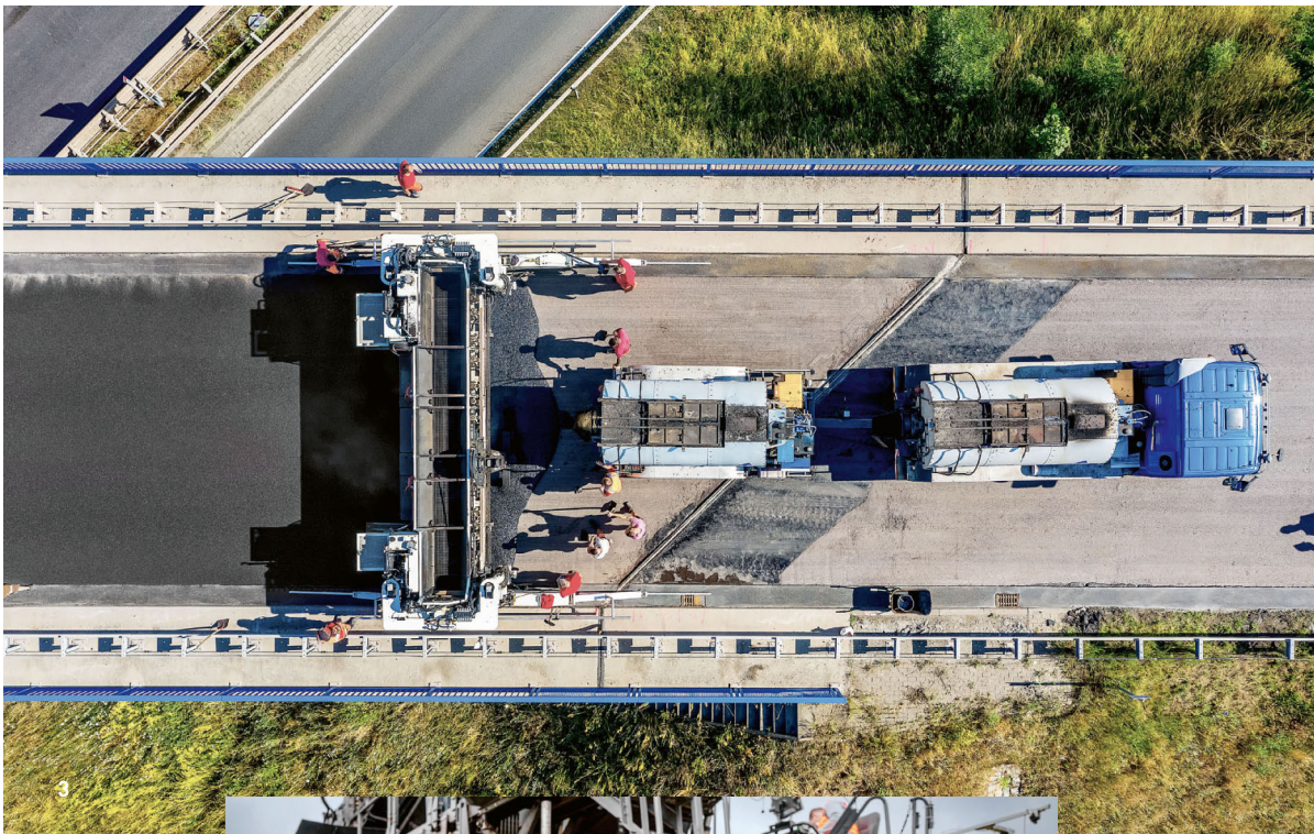
3 Einbau des Gussasphalts / 4 Verlegung von Sensoren zur Schichtdickenmessung
