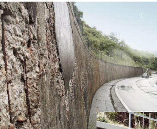
1 Betonschäden vor der Instandsetzung/
