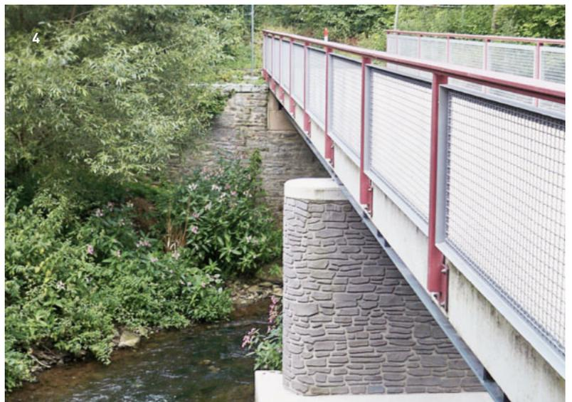
1 Hilfsmatrix auf Pfeilerschale / 2 Montage der vorgefertigten Spritzbetonpfeilerschale / 3 Spritzbetonauftrag / 4 Ausbetonierte Spritzbetonpfeilerschale mit Oberfläche TORKRET Relief®
