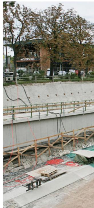
1 Matrice auf Spritzbeton mit rückwärtigen GEWI-Ankern/
