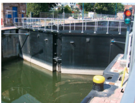
4 Stemmtore Hameln/ 5 GuD-Kraftwerk Lausward, Düsseldorf, Stahlbau mit beleuchteter Fassade/ 6 Stabbogenbrücken über die A100, Berlin
