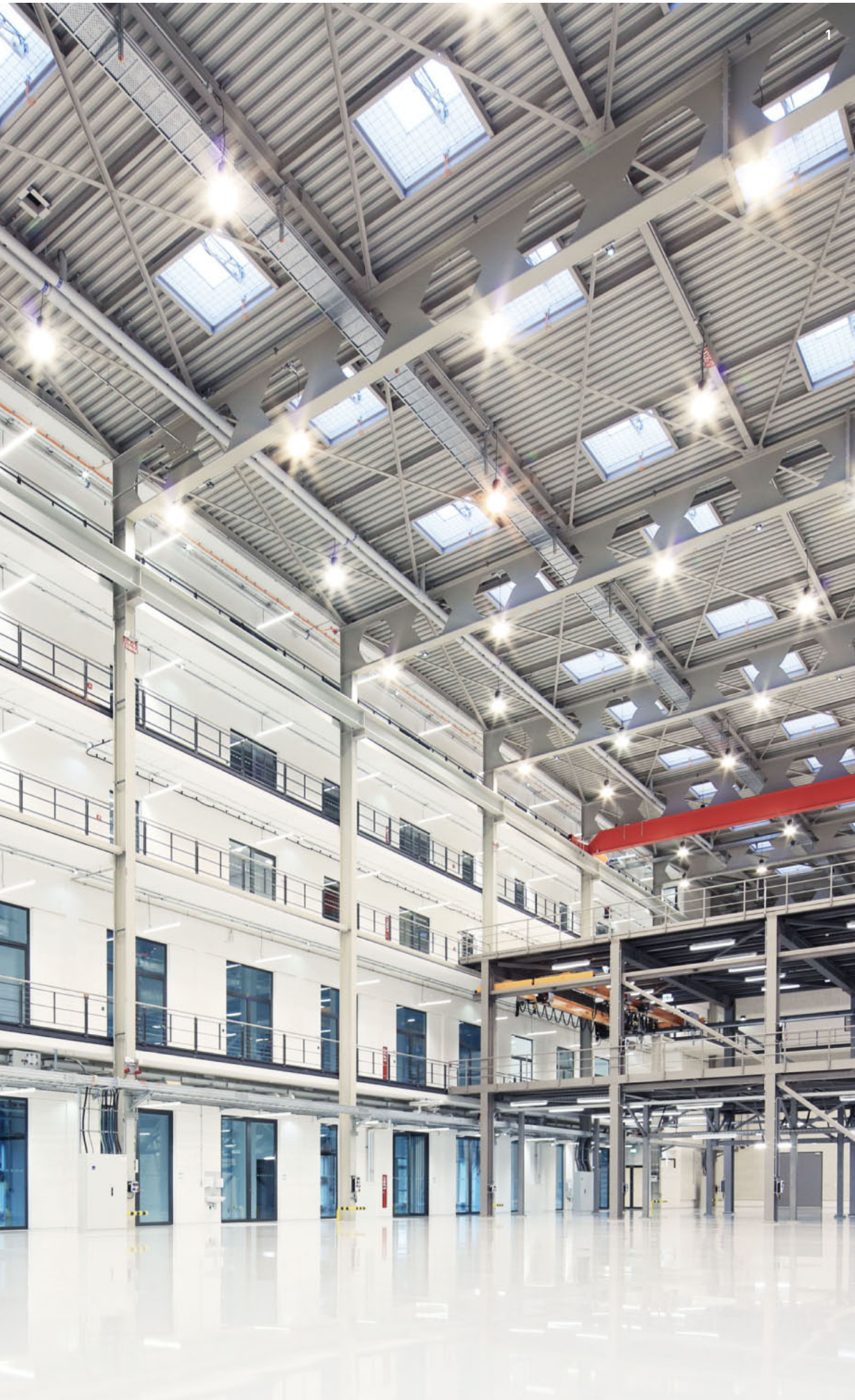
Cover: Zweibrückenstraße Hamburg + Kraftwerk Amager RC, Kopenhagen (Dänemark) 1 ZAL Forschungszentrum, Finkenwerder
