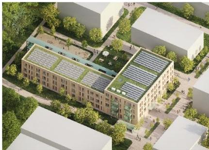
Die Dachflächen des Gebäudes werden begrünt und mit einer Photovoltaikanlage zur nachhaltigen Energiegewinnung ausgestattet.
