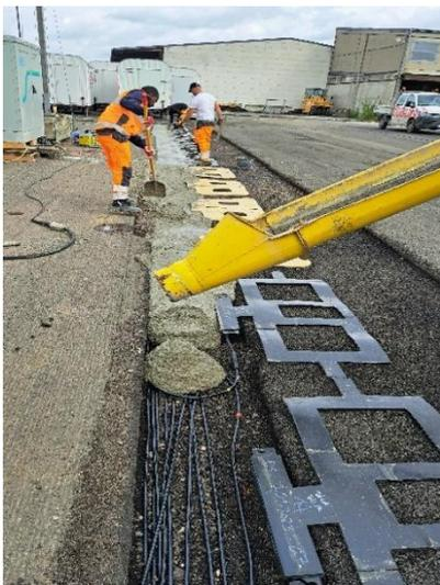
Beschreibung: Für den Einbau werden die Kondensatoren der Spulen zuerst einbetoniert. Anschließend wird alles mit einer Asphaltsschicht bedeckt.
