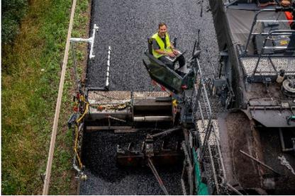
Teilautomatisierung des Asphalteinbaus für höhere Arbeitssicherheit und besseren Gesundheitsschutz: Kontrollaufgaben sollen Mitarbeitende statt an der Einbaubohle künftig aus der Fahrerkabine des Fertigers (unten) wahrnehmen – auf Distanz zum fließenden Verkehr sowie zu giftigen Dämpfen und Aerosolen.
