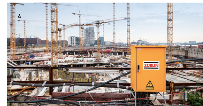
1 Stadtbahntunnel, Karlsruhe / 2 Terminal T3, Flughafen Frankfurt / 3 Baustelleneinrichtungsplan / 4 Überseequartier, Hamburg
