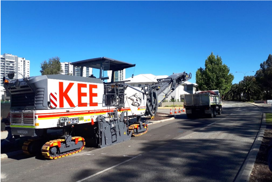
Mit der geplanten Übernahme von KEE Surfacing erweitert STRABAG ihre Wertschöpfungskette in Westaustralien © KEE Surfacing
